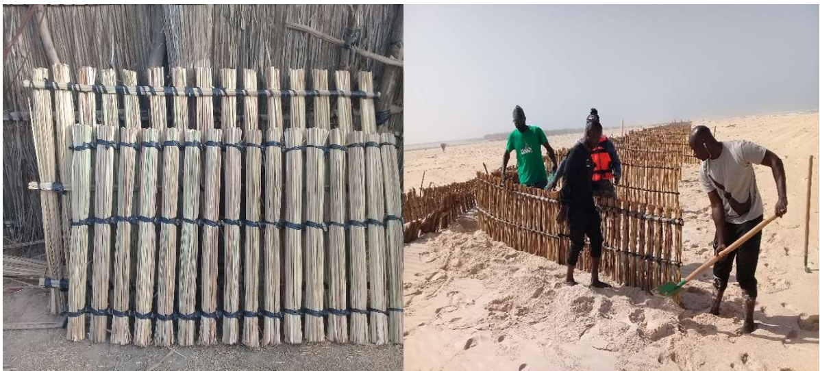
Photos 1 : Installation des typhavelles
